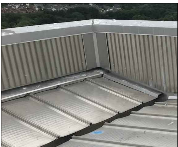
Dettaglio Canale di gronda su lamiera tipo Riverclack
